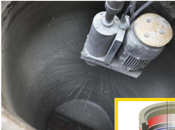
Eine Sonde wird in den Kanalschacht hinuntergelassen und schleudert den neuen Verputz gleichmäßig auf die Innenwand (siehe auch Illustration rechts).
