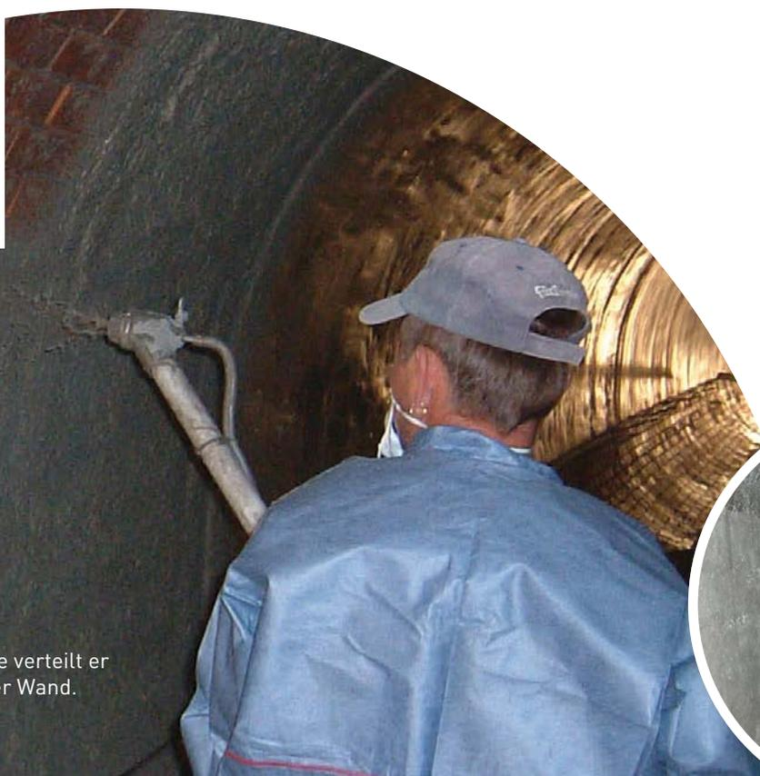
Der Spezialist vor Ort im Kanal. Mittels einer speziellen Sprühpistole verteilt er die Beschichtung gleichmäßig an der Wand.
