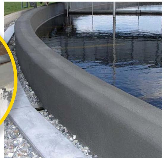
Die oberen Abschlüsse von flüssigkeitsbewahrenden Bauwerken wie z. B. Klärbecken sind der exponierteste Bereich. Sie sind jahrein jahraus allen Witterungen und zahlreichen klimatischen Bedingungen ausgesetzt. Das bleibt nicht ohne Wirkung: Risse, Löcher, Schimmel und Frostschäden können die Folge sein.
